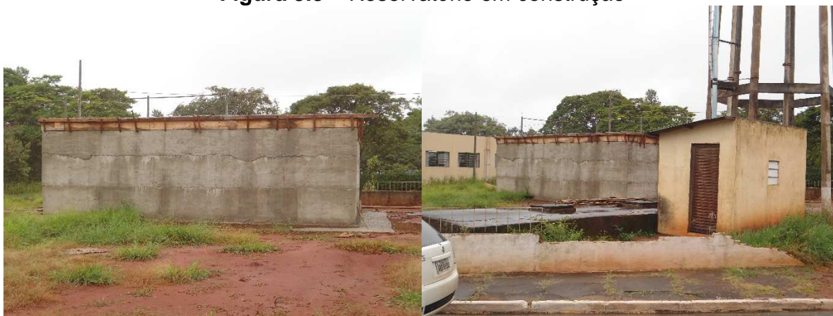
Figura 3.8 – Reservatório em construção
