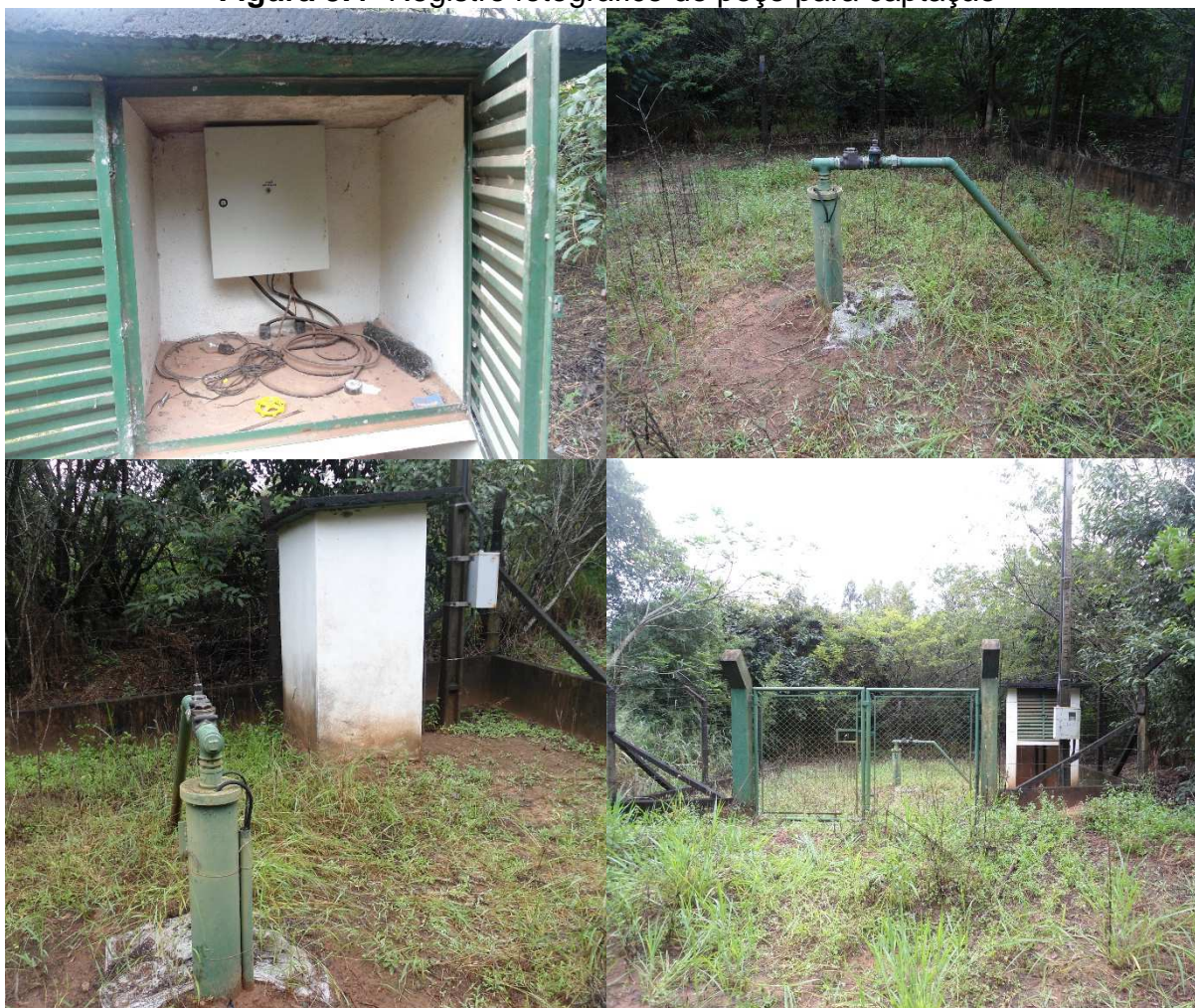
Figura 3.4- Registro fotográfico do poço para captação
