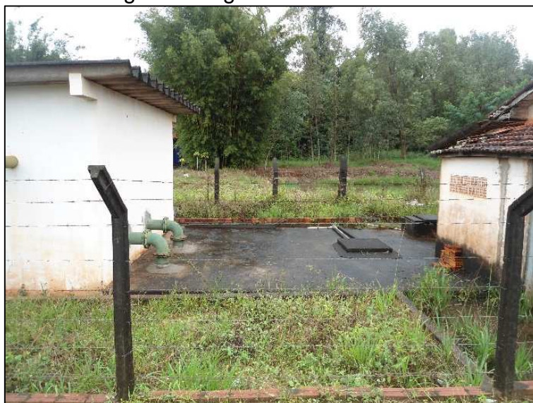
Figura 3.6 – Registro fotográfico do Reservatório de acumulo
